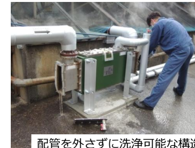
配管を外さずに洗浄可能な構造
