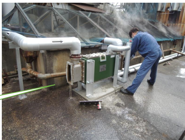
ジェット洗浄による洗浄作業
