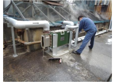
側面を開放しての直接ジェット洗浄
